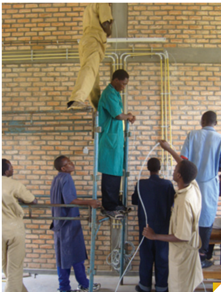
Formation des formateurs, filière électricité des Ecoles secondaires techniques
